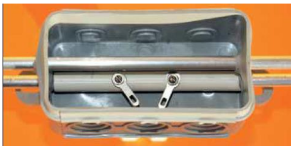
Fot. 5.4.7. Montaż elementów w puszcze
