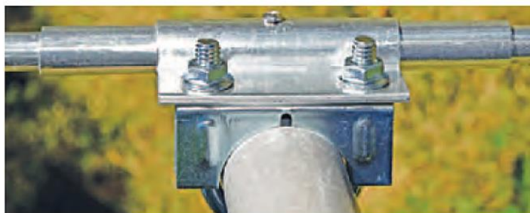
Rys. 5.3.3. Montaż elementów do nośnika
